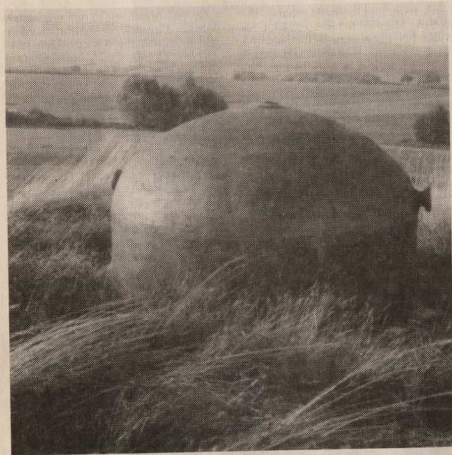
Die Stahlkuppel eines Kampfstandes
