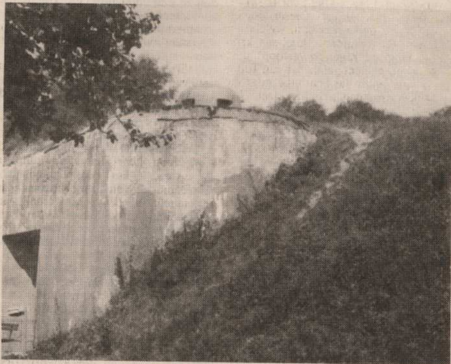
Der Westeingang des „Kalkofens“ mit der Kuppel eines Kampfstandes
